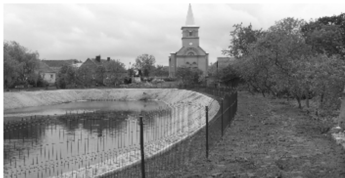
Zbiornik przeciwpożarowy w Rogozińcu
