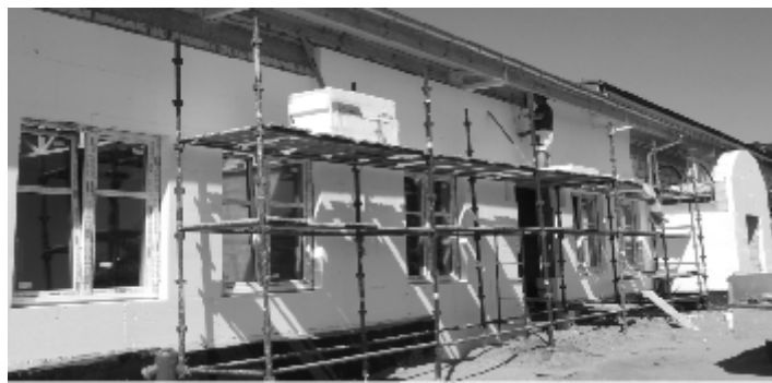
Prace przy ocieplaniu CKiF w Dąbrowce Wlkp.
