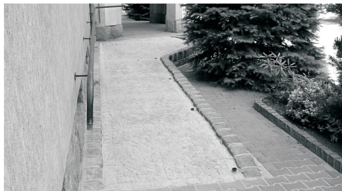
Podjazd dla niepełnosprawnych do Urzędu Miejskiego
