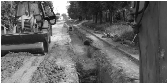
Prace przy budowie kanalizacji na ulicy PCK
