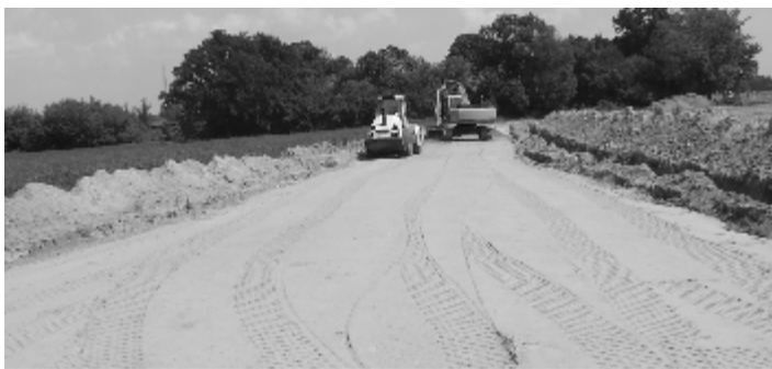
Prace przy budowie obwodnicy Zbąszynka
